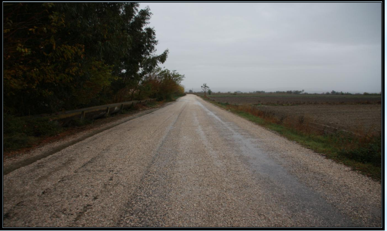
Kadirli - Dervişli –Tatar - Karabacak Grup Yolu 2. Kat Asfalt Kaplama
